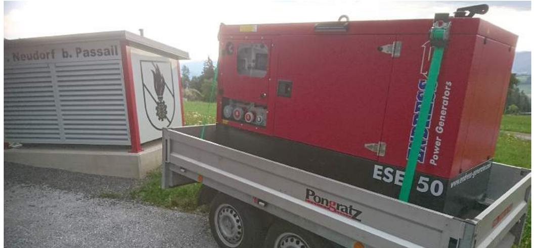
Mit den Aggregaten Stationär 45 KVA mit automatischem Anlauf und Umschaltung und dem mobilen 50 KVA ist die FF Neudorf gut aufgestellt.
